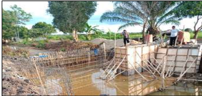
Gambar 11. Perbaikan Pintu Air Membawa Implikasi Teknis (Sumber : Dokumentasi Penulis, 2022)
