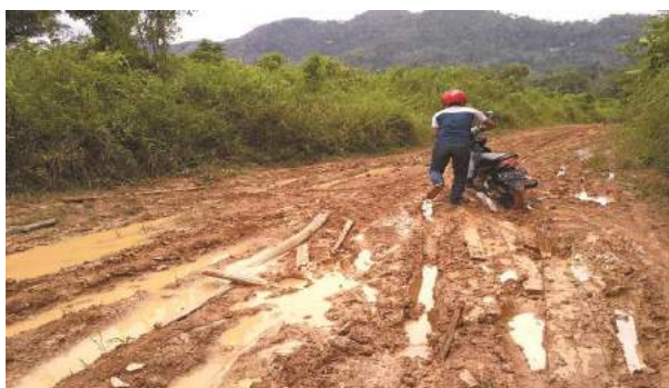
Gambar 13 Akses jalan menuju wisata yang sulit
